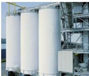
CONTROL DE NIVELES
